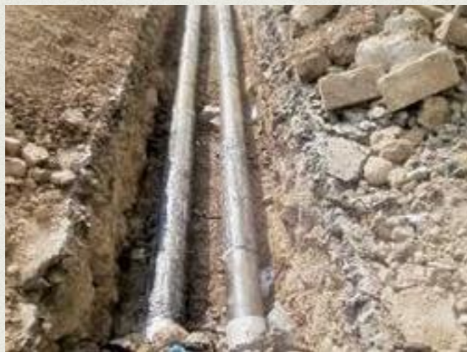
120 m Tube PP 42x1,5 mm 83 m Tube PP 35x1,5 mm
